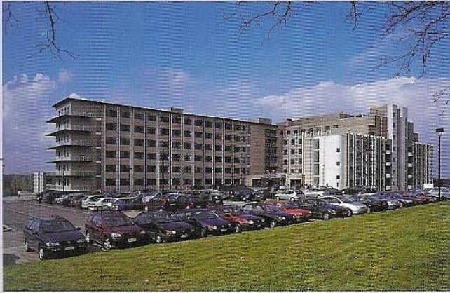
Doordat de twee bestaande blokken een volledig nieuw kleedje kregen gaan ze in perfecte harmonie samen met het nieuwbouwgedeelte.
